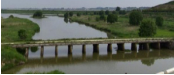
〈사진 2〉 태인천에 놓인 콘크리트다리(사진 3의 ○ 표시). 지금은 새로 다리가 놓이면서 폐쇄되었다.
